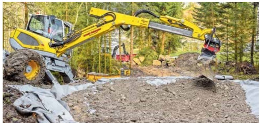
Der erfahrene Maschinenführer bringt im oberen Teich die schützende Deckschicht auf die Kautschuk-Teichfolie auf.
