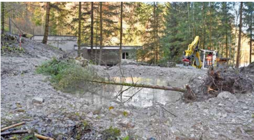
Der obere Teich ist schon fertig, währenddessen der Bagger den grösseren Teich aushebt.
